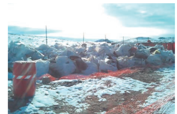
Big bags conteniendo residuos sólidos contaminados, sobre suelo natural. Fuente: DRP.
